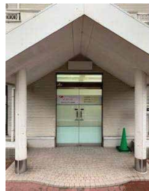
（新事務所玄関出入口）
